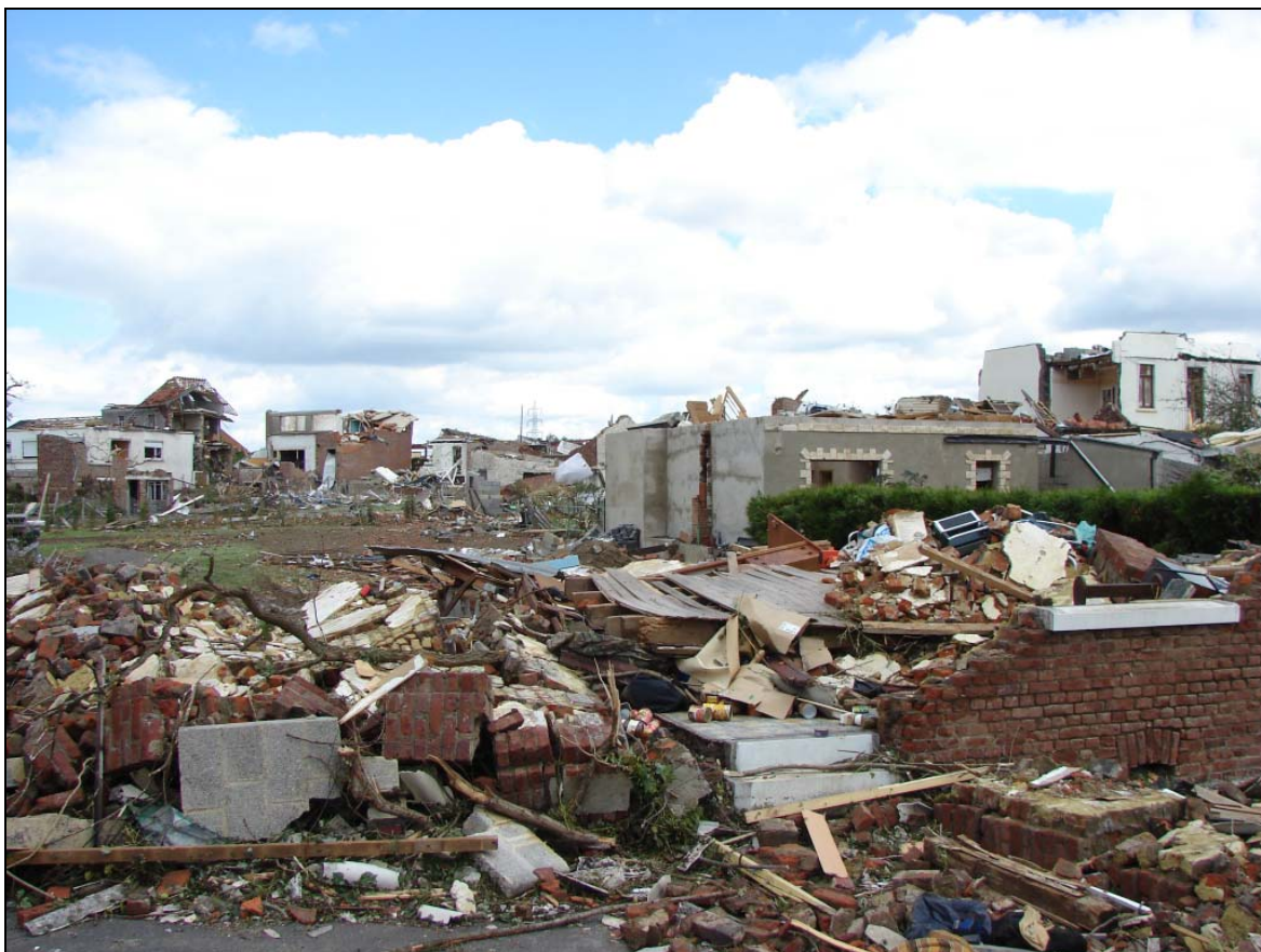
Het huis (of wat daar van over blijft) op de voorgrond is totaal verwoest tot op de grond. Hier kijken we in de richting van het schadespoor. De schade is hier het meest uitgebreid
