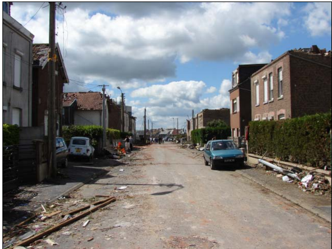
de windhoos trok grotendeels evenwijdig met deze straat en elk huis heeft hier schade en talrijke daken zijn vernield
