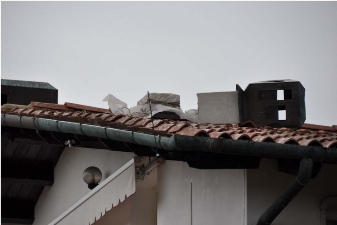
Camino caduto a poche decine di metri dal touchdown. E' uno dei primi danni rilevati, eccezion fatta per asportazione di tegole e coppi da alcuni tetti nelle vicinanze. (Foto di Glora Cariolato - SerenissimaMeteo)
