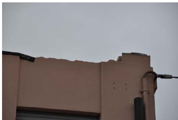
F2-F3-F4: Foto abitazione 1 con particolari sulla quasi totale asportazione dell'impalcato di copertura (strutture di sostegno e ponte del tetto)
