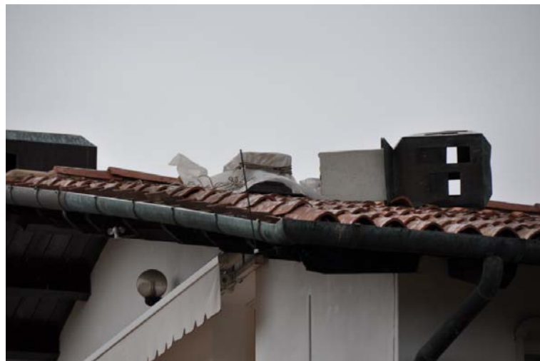
F25-F26: Foto abitazione5 con particolari sul crollo del camino
