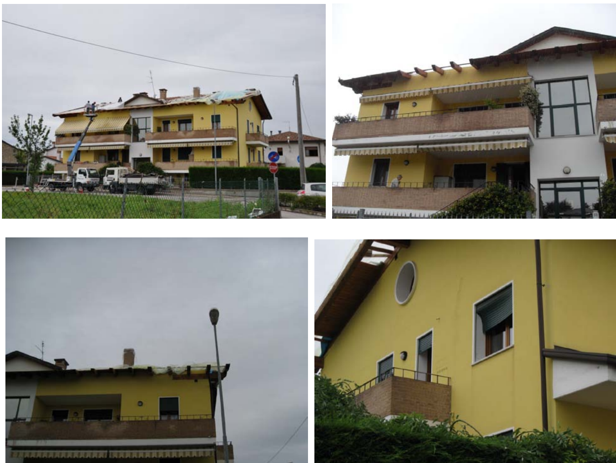
F17-F18-F19-F20: Foto abitazione2 con particolari sul parziale sollevamento del ponte del tetto in legno (tavolato)
