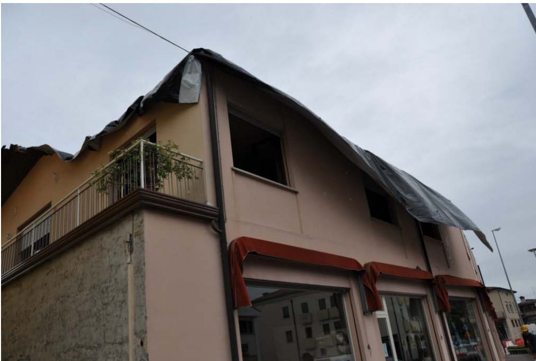
Parte della casa maggiormente colpita per asportazione completa del tetto. Si può osservare come i venti abbiano asportato il tetto, ma non le tende parasole del piano terra. (Foto di Glora Cariolato - SerenissimaMeteo)
