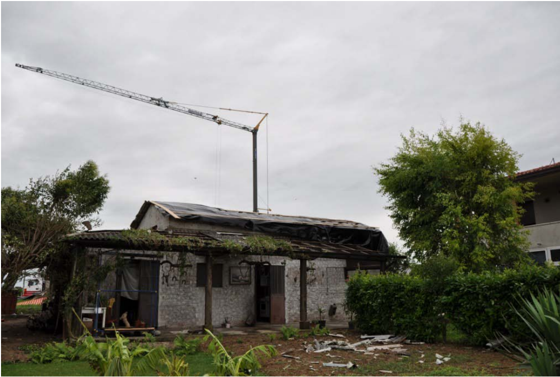
Costruzione senza copertura (eternit). (Foto di Giora Cariolato - SerenissimaMeteo)
