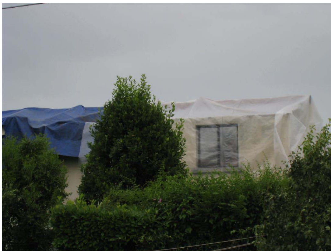
Casa con tetto in eternit completamente scoperchiata. (Foto Tobia Scortegagna – SerenissimaMeteo)
