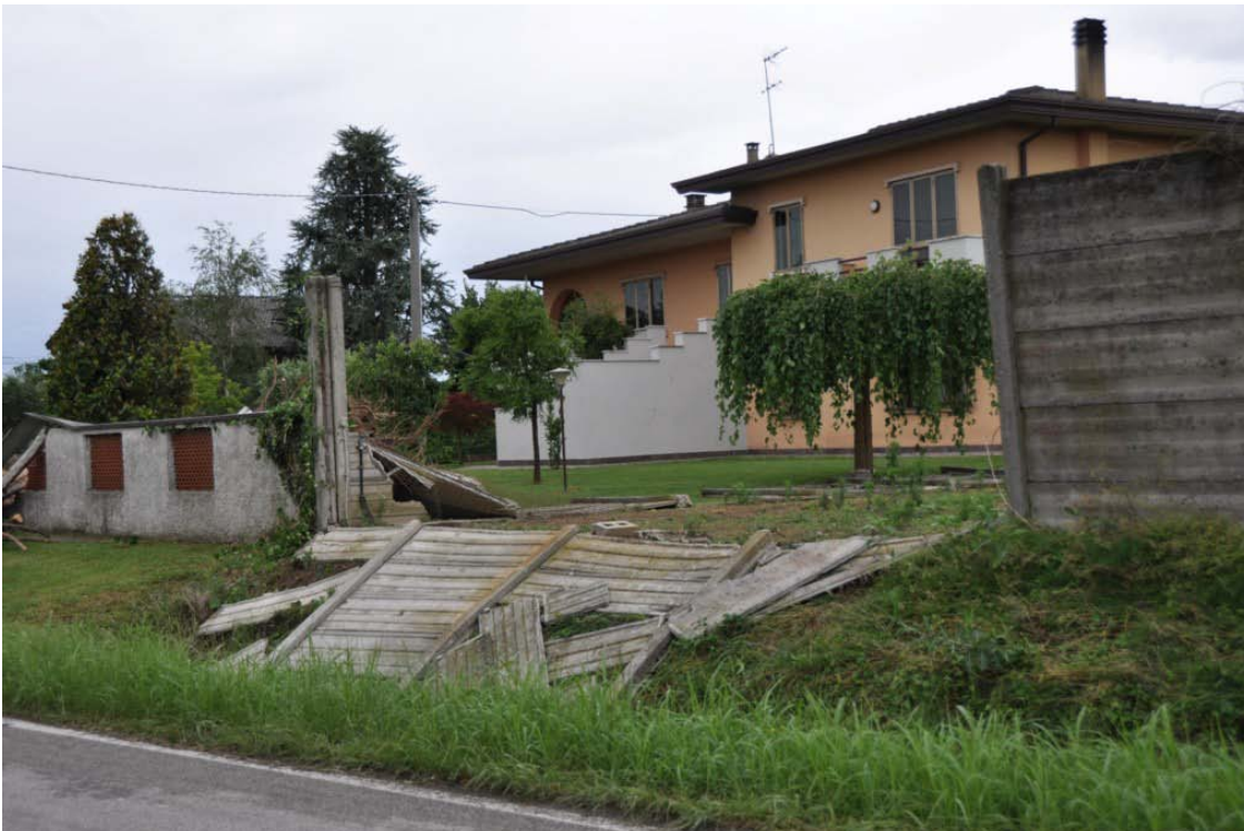
Muro in pannelli di cemento prefabbricati abbattuto. L'abbattimento è stato causato da un albero sradicato a ridosso del muro. (Foto di Giora Cariolato - SerenissimaMeteo)
