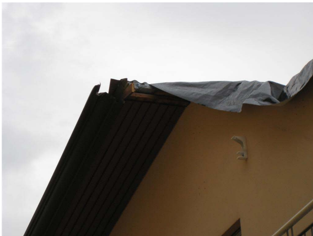
Particolare della copertura del tetto della casa maggiormente colpita in seguito a completa asportazione del tetto. Si nota che la struttura del tetto è di tipo leggero. (Foto di Tobia Scortegagna - SerenissimaMeteo)
