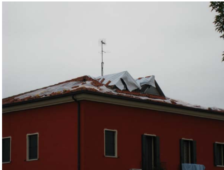
F21-F22: Foto abitazione3 con particolari sulla perdita limitata della copertura del tetto (parziale asportazione del manto in tegole di laterizio)
