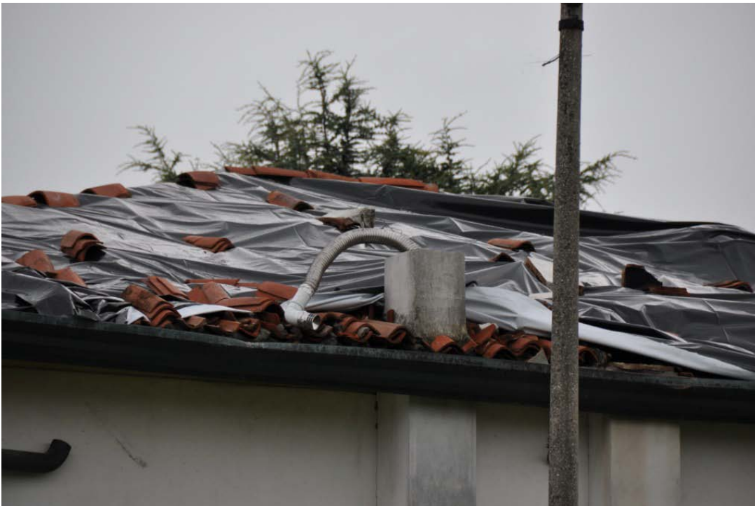
Particolare della casa lungo la SP sud. Notare il comignolo asportato e il tubo di una caldaia risucchiato lungo il camino. (Foto di Giora Cariolato - SerenissimaMeteo)
