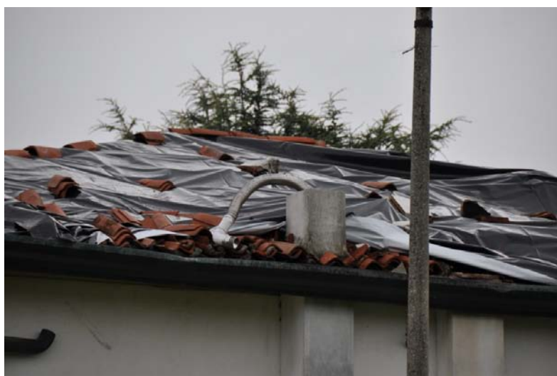
F23-F24: Foto abitazione4 con particolari sulla perdita limitata della copertura del tetto (parziale asportazione del manto in tegole di laterizio e della grondaia)
