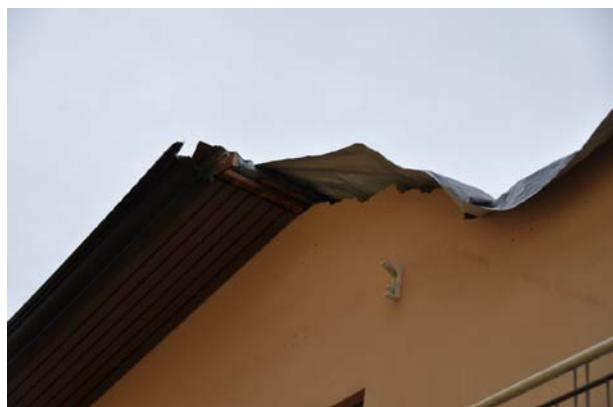
F2-F3-F4: Foto abitazione 1 con particolari sulla quasi totale asportazione dell'impalcato di copertura (strutture di sostegno e ponte del tetto)
